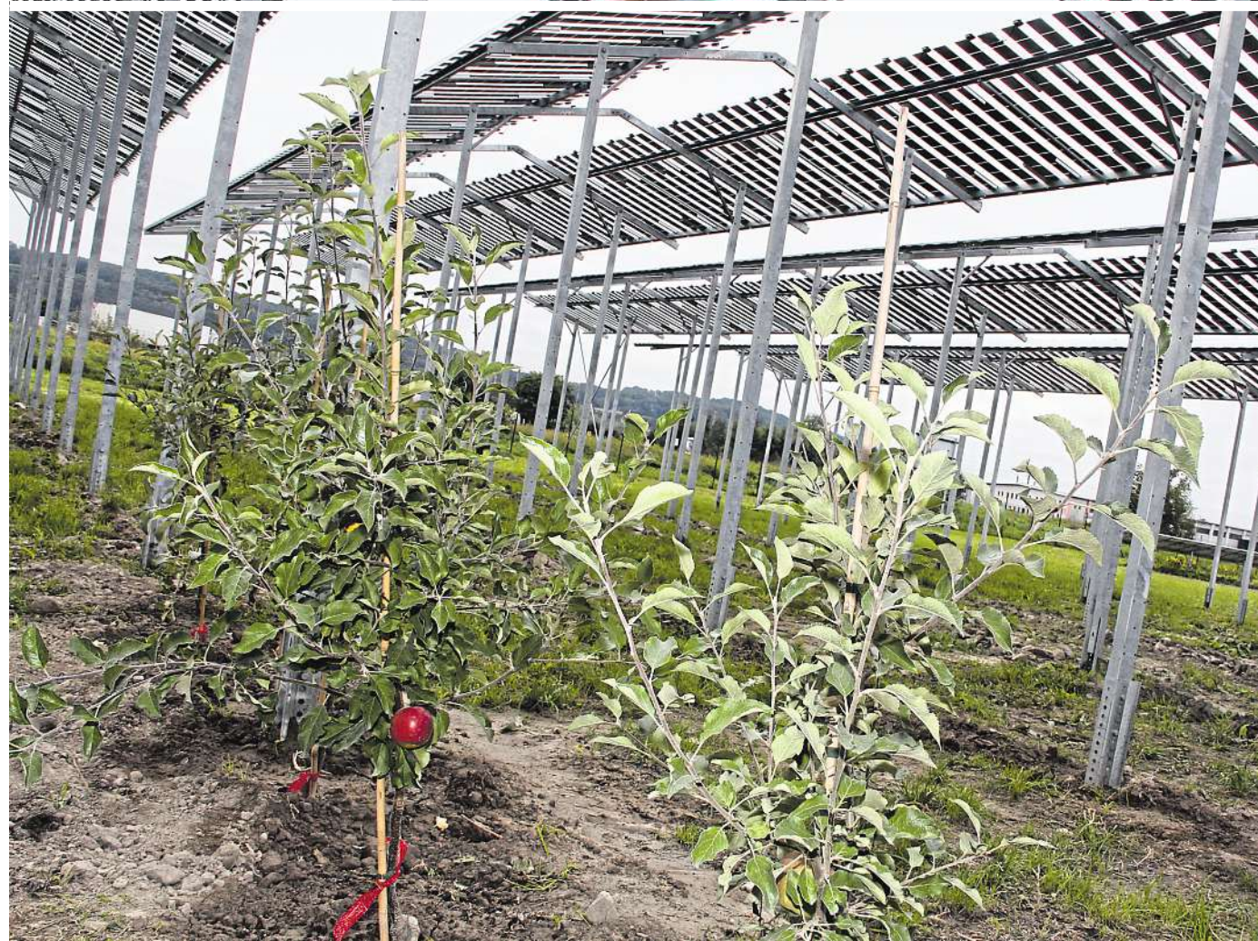
Spezielle hochgestellte und lichtdurchlässige PV-Paneele (Agri-PV) ermöglichen in Pöchlarn Apfelbäumen unter den Modulen das Wachsen
