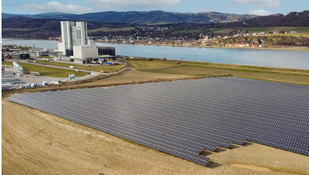
Auf einer Fläche von 5 ha entsteht bei Pöchlarn/Niederösterreich eine Photovoltaikanlage mit über 4 MWp, die teilweise mit Apfelbäumen bzw. Beerenobstkultur kombiniert wird.
