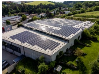
Privatbrauerei Zwettl 332 kWp
