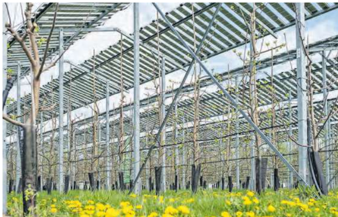
Rund 35 % des Lichts können durchscheinen. Das Obst wird auf einer Höhe von vier Metern mit aus Siliziumzellen bestehenden Paneelen überschirmt.
